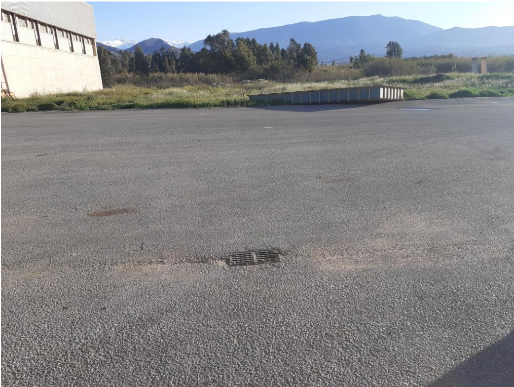
Fotografía nº 4.-Ubicación de uno de los imbornales existentes
